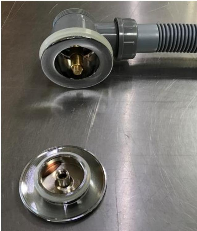
2. Messingeinsatz (roter Pfeil) mit 10er-Schraubenschlüssel abschrauben
