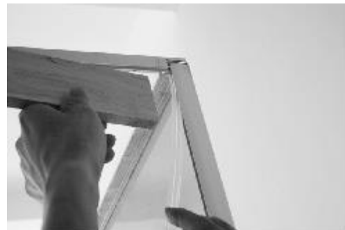
Gummi des linken und rechten unbeweglichen Glases an Alu-Rinne und Verbindung des Rückenpanels befestigen
