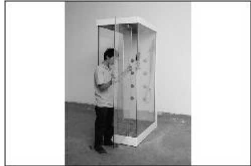
Bewegliche Glastür montieren
