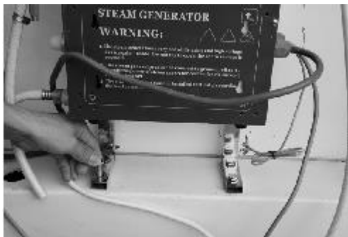
Kontrollkasten und Dampfer montieren
