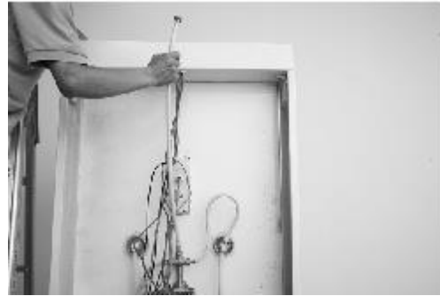
Eingangsrohr durch das gebohrte Loch am Dach durchstecken
