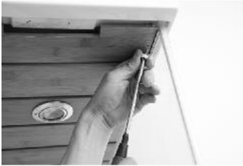
Verschraubung von Dach und Bambusdach montieren
