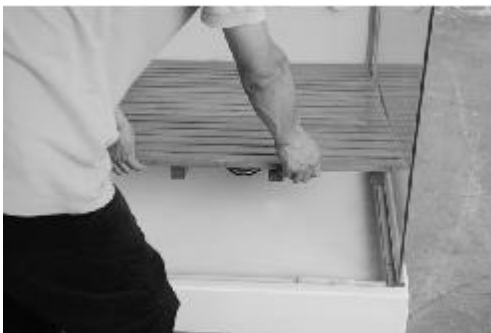
Bambusboden montieren
