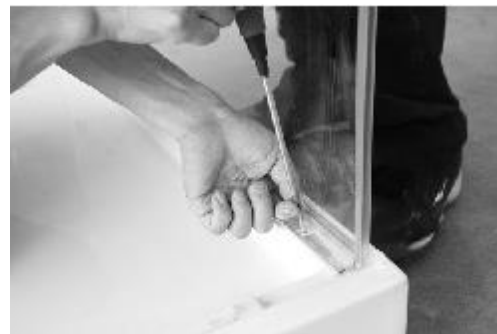
Verschraubung von rechtem, unbeweglichem Glas und Ablage montieren
