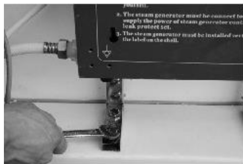
Verschraubung von Unterlage, Kontrollkasten und Dampfer anbringen
