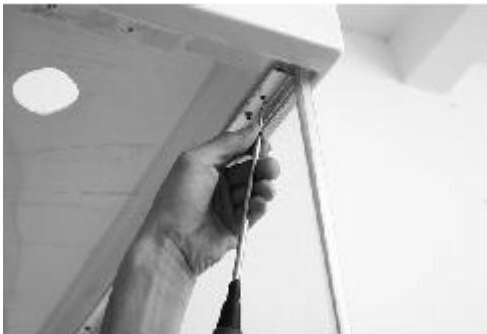
Verschraubung von Dach und Seitenpaneel montieren
