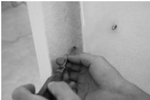
Verschraubung montieren und festziehen
