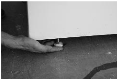
Wannenfüße anbringen und sicherstellen, dass die Duschablage in horizontaler Ebene ist
