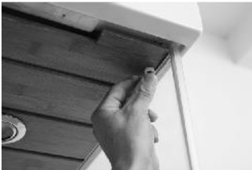
Schraube mit dekorativer Kappe abdecken
