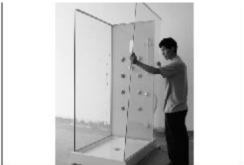
Rechtes, unbewegliches Glas montieren
