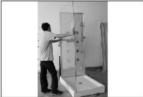
Linkes, unbewegliches Glas aufrecht in die Ablage stellen
