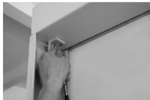
Verschraubung von dekorativem Paneel und Dach anbringen
