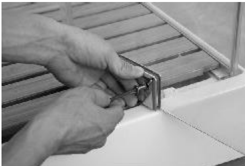
Schraube von Scharnier anbringen, um das bewegliche Glas zu befestigen
