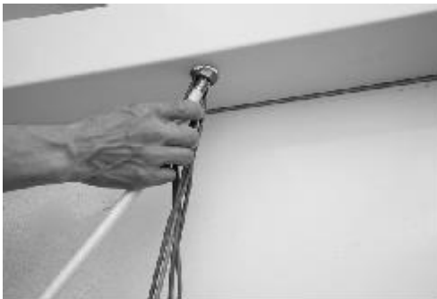
Eingangsrohr der oberen Brause montieren
