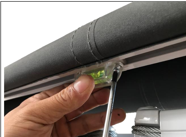
Anbringen der Wasserwaage in der Mitte der Markise
