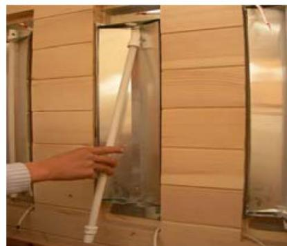
D.4.1.5 Schließen Sie die beiden Verbinden an beiden Enden der Röhre an und fixieren Sie die Keramik-Abdeckungen an beiden Seiten
