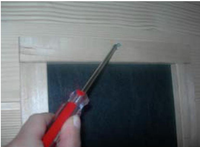
D.4.2.2 Trennen Sie die Verbindung zwischen Heiz-Platine und Sauna-Kabine
