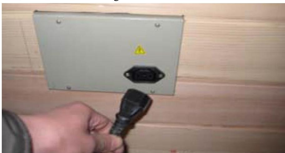
D.2.4 Richten Sie das Dach auf die obere rechte Ecke aus und führen Sie die Kabel für die Heizung durch die dafür vorgesehenen Löcher in der oberen Platte. Schließen Sie die Kabel an das Stromnetz an.
