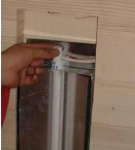
D.4.1.6 Bringen Sie den Clip im unteren Bereich der Heizungs-Abdeckung an
