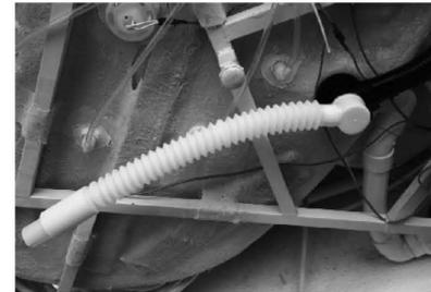
9. Setzen Sie den Abflussschlauch in die Abflussöffnung des Bodens.
