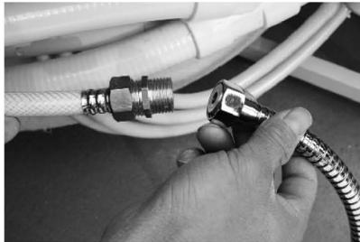
3. Schließen Sie den Brauseschlauch am Wasserschlauch an.
