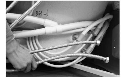
10. Schließen Sie nun die Rohre für kaltes und warmes Wasser separat an.
