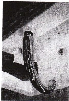
4. Setzen Sie die Dichtung an und befestigen Sie nun unten mit einem Mautschlüssel die Schraube des Wasserfalls.
