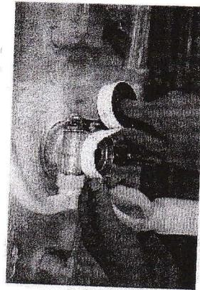
6. Mit dem Gewindedichtungsband umwickeln Sie das Abflussrohr.
