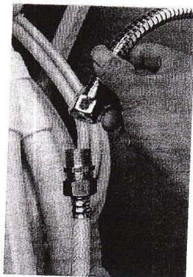
3. Schliessen Sie den Brauseschlauch am Wasserschlauch an.
