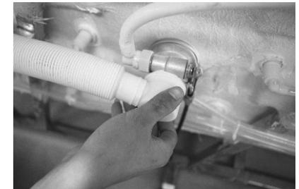
4. Befestigen Sie den Abflussschlauch.
