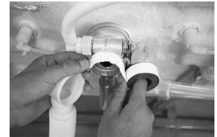
2. Mit dem Gewindedichtungsband umwickeln Sie das Abflussrohr.
