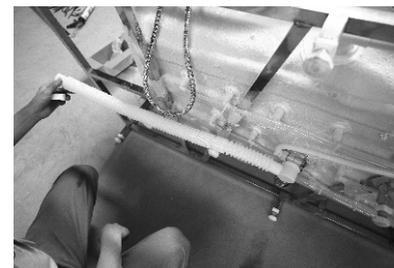
5. Setzen Sie den Abflussschlauch in die Abflussöffnung des Bodens.
