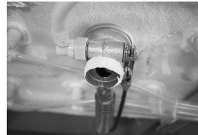
3. Streichen Sie das wasserdichte Gewebedichtungsband glatt.
